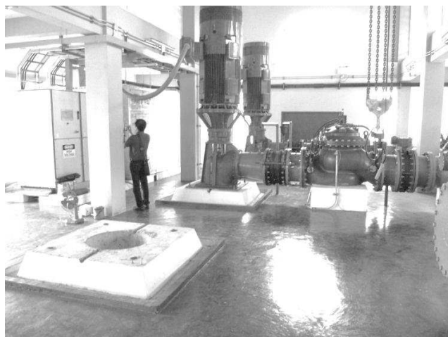
รูปที่ 2-32 เครื่องสูบน้ำแบบเทอร์ไบน์ (Vertical Turbine Pump)
