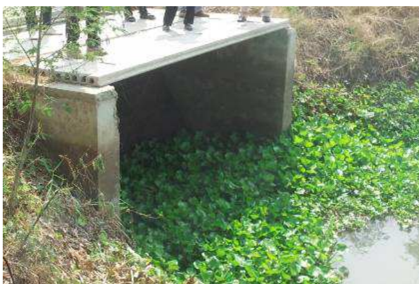
รูปที่ 1-10 แสดงปากรางรับน้ำดิบ
