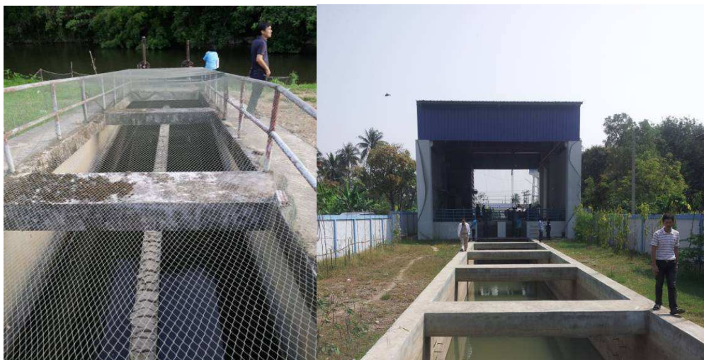
รูปที่ 1-11 แสดงตัวรางชักน้ำดิบ
