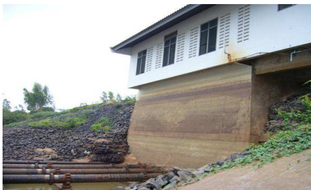
รูปที่ 1-13 แสดงโรงสูบน้ำแรงต่ำ แบบบ่อแห้ง
