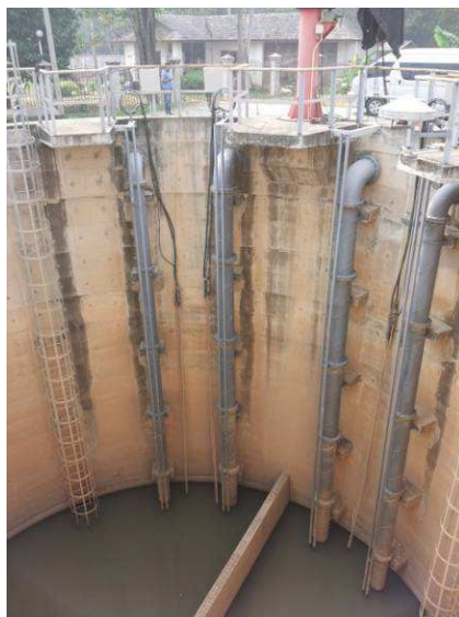
รูปที่ 1-20 แสดงบ่อสูบน้ำ (กปภ.สาขาแพร่)
