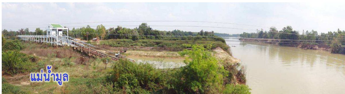
รูปที่ 1-16 แสดงโรงสูบน้ำแรงต่ำ แบบรางเลื่อน (กปภ.สาขาสตึก น.พทุธสง)
