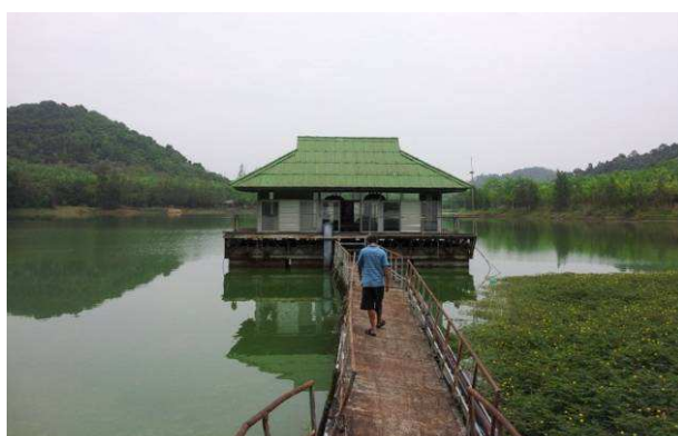
รูปที่ 1-18 แสดงโรงสูบน้ำแรงต่ำ แบบแพลอย (กปภ.สาขาปากน้ำประแสร์)
