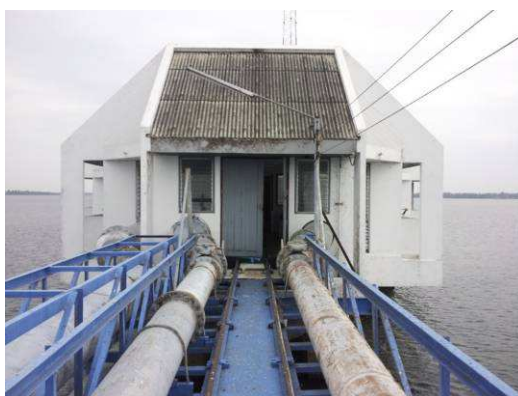
รูปที่ 1-14 แสดงโรงสูบน้ำแรงต่ำ แบบเทอร์ไบน์ (กปภ.สาขาสุรินทร์)
