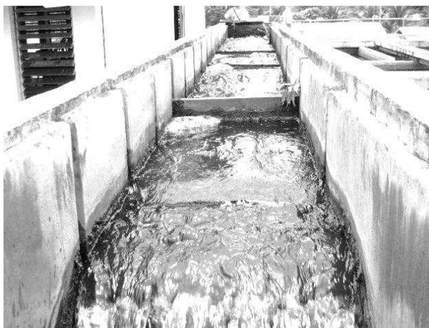
รูปที่ 2-13 ถังกวนช้าแบบแผงกั้นไหลในแนวดิ่ง
