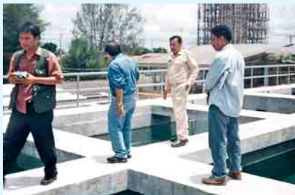
สำนักงานประปาอุดรพนม - เชื้อเชิญสื่อมวลชนมาชมถังตกตะกอน ซึ่งเป็นกระบวนการหนึ่งที่ทำให้น้ำจากธรรมชาติ เริ่มมีความใสและสะอาดขึ้น
