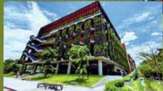
อาคารเรียนรวม 3 (SC 3)
