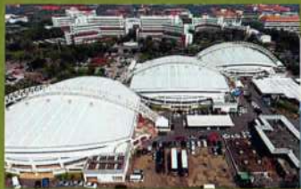
อาคาร GYMNASIUM 4 - 5 - 6
