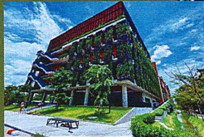
อาคารเรียนรวม 3 (SC 3)
